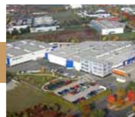
KORDSA FACTORY Коджаэли
